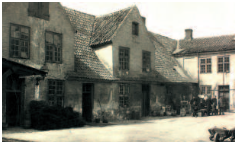
Gårdparti fra Københavns Tvangs- og Arbejdsanstalt. Bygningen med de to kviste er den sydlige fløj, der vendte ud mod Ladegårdsmarken. En del af fløjen stammede fra en ombygning i 1750'erne og stod, indtil ladegården blev nedrevet i 1930. Foto omkring 1895.
